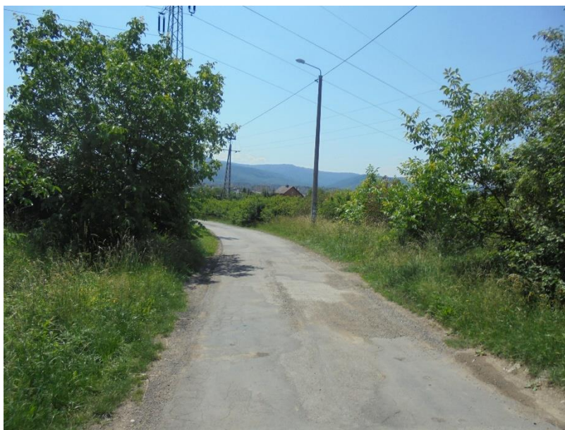
Rysunek 19 Stan nawierzchni na ul. Portowej
