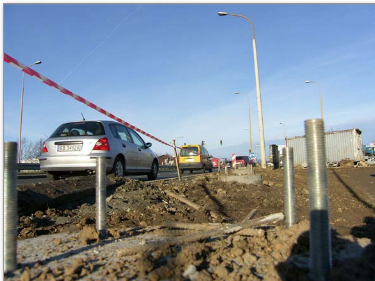
2006 r. montowanie ekranów przy ul. Andersa
