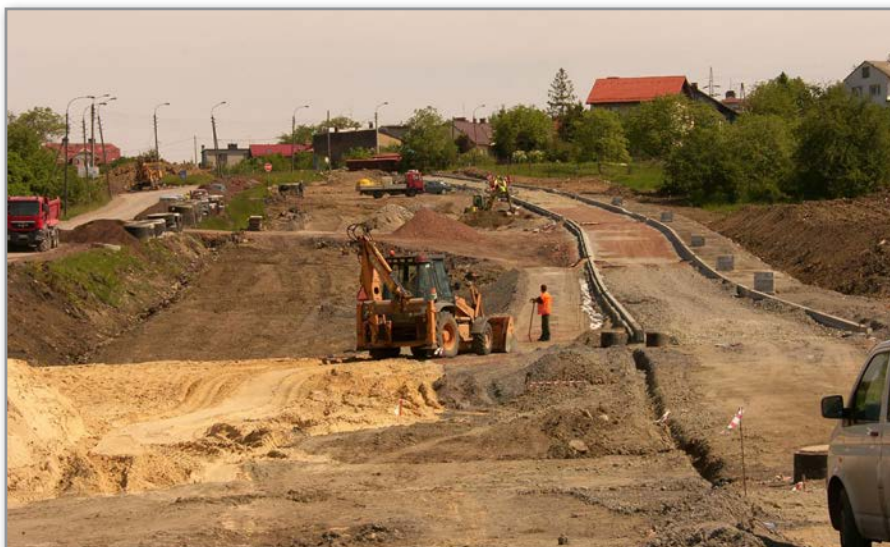
Ul. Wyzwolenia w budowie
