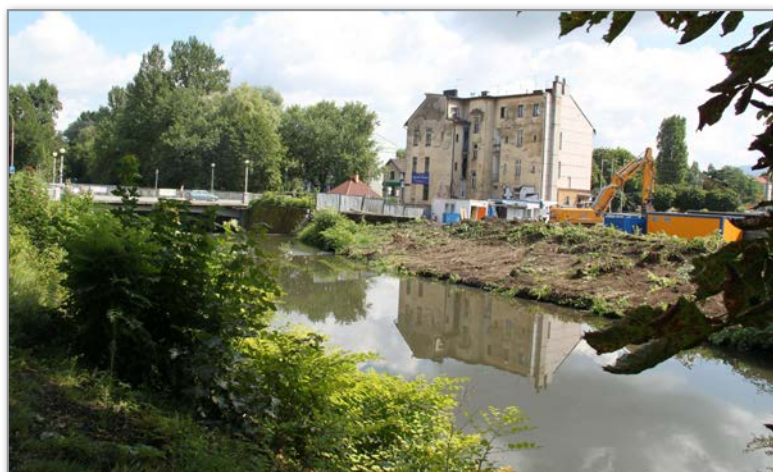
Remont mostu na ul. PCK – sierpień 2012 r.
