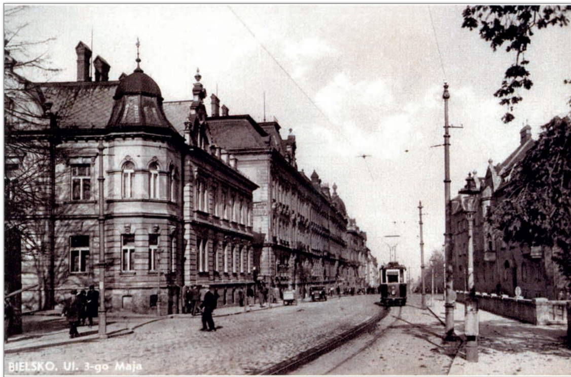
ul 3 Maja po 1927 r. po przebudowie torowiska
