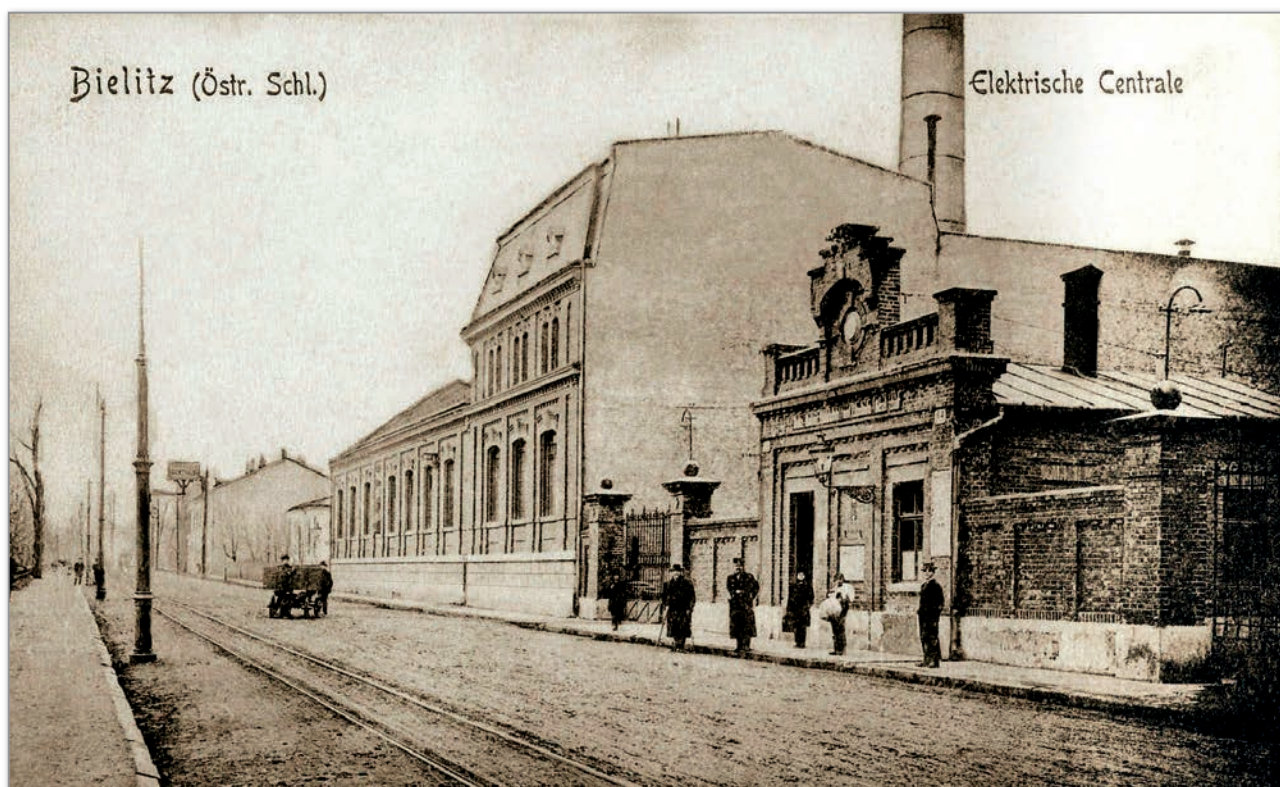
Bielsko, ulica obok elektrowni
