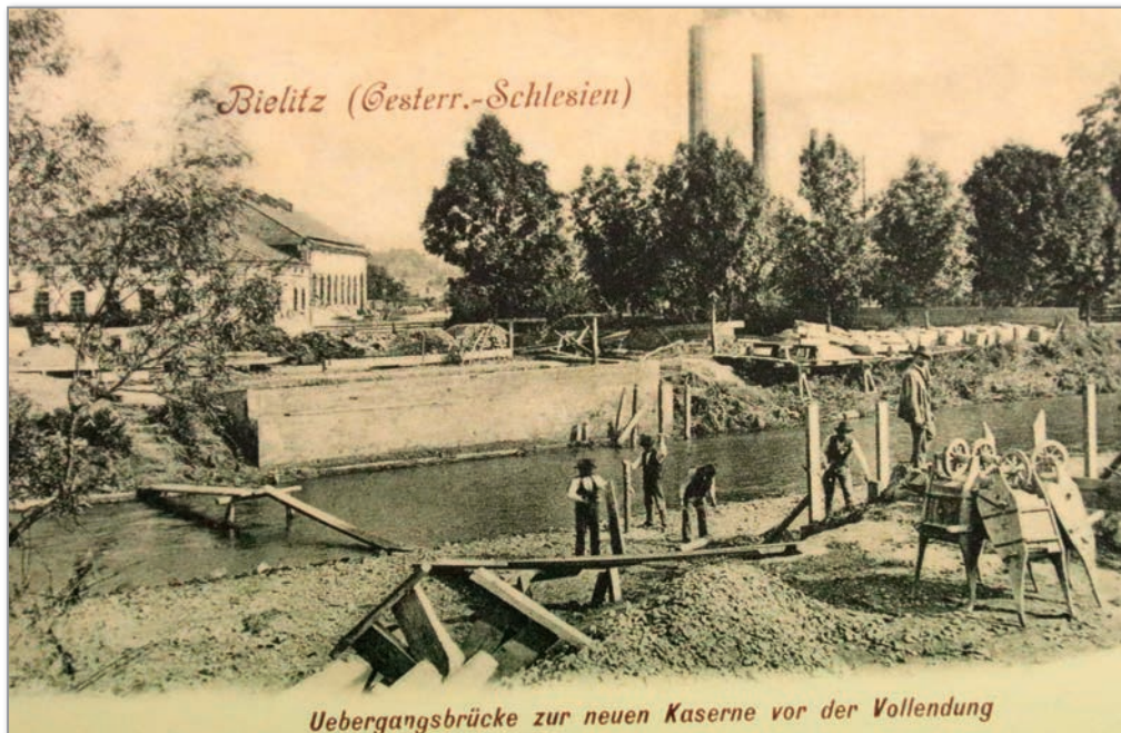
Budowa mostu do koszar, 1902 r.
