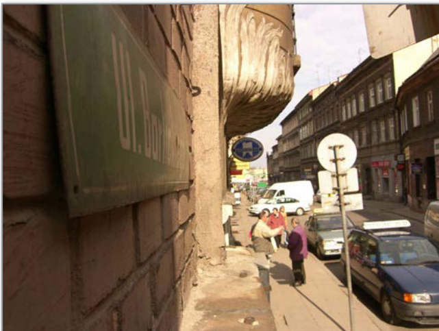
Ul. Barlickiego przeznaczona do remontu – luty 2009 r.
