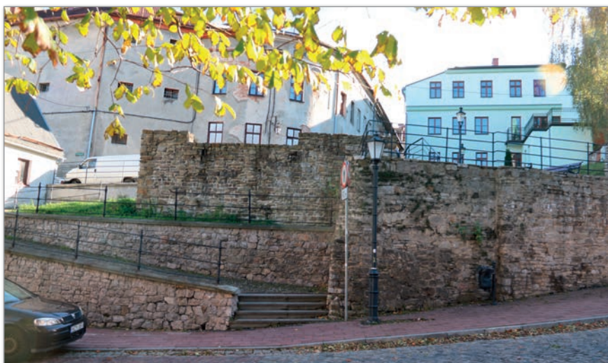
Mur przy ul. Orkana
