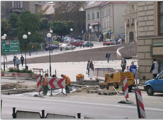
Roboty przy przejściu podziemnym na ul. 3 Maja
