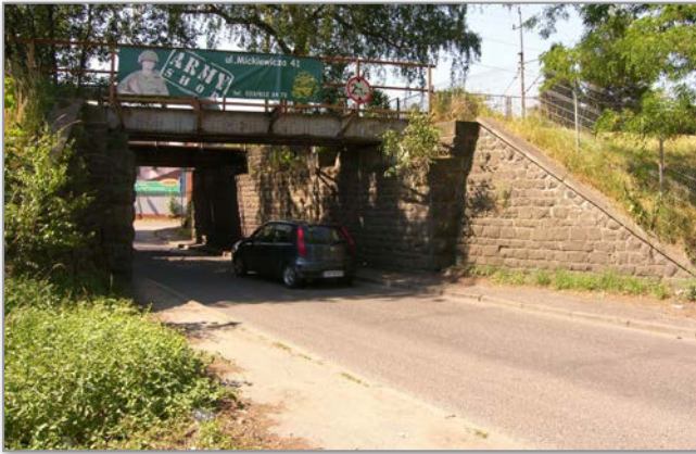
Wiadukt na ul. Grażyńskiego do przebudowy
