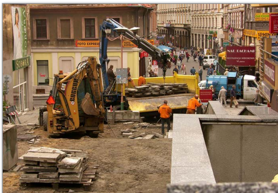
Sierpień 2007 r. remont schodów przy ul. Barlickiego
