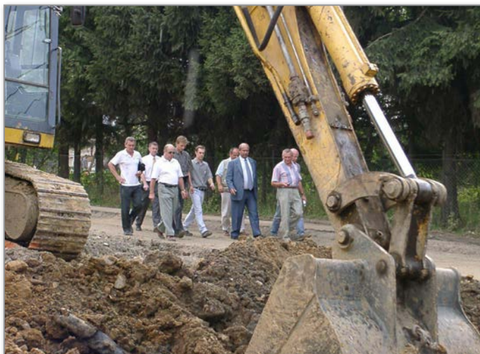
Prace przy budowie na ulicy Armii Krajowej
