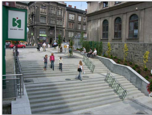
Schody przy ul. Przechód – czerwiec 2008 r.
